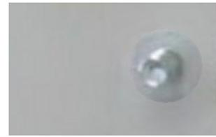
Abb. 24: Nicht gekennzeichnete Erdungsbolzen
