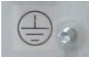
Abb. 23: Erdungsbolzen gekennzeichnet mit PE-Symbol
